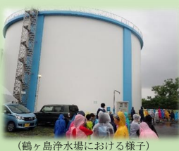
(鶴ヶ島浄水場における様子)
