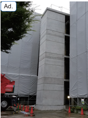
PCaPC による EV 棟増築の事例
