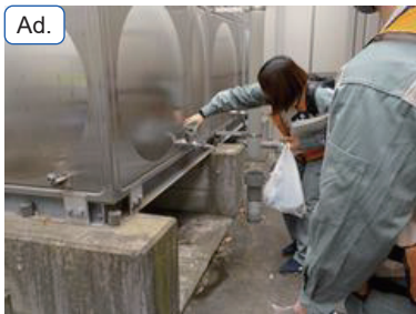
受水槽への非常用給水栓設置の事例
