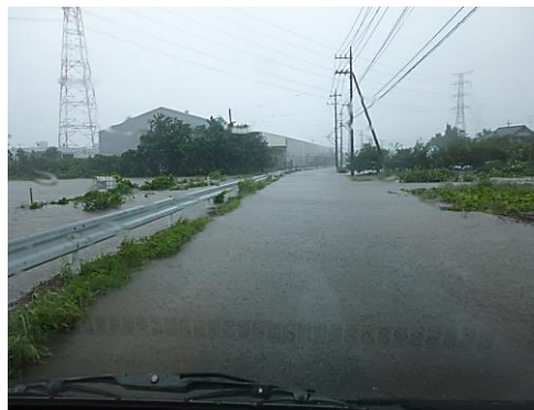
鶴ヶ島市内市道：道路冠水の様子
