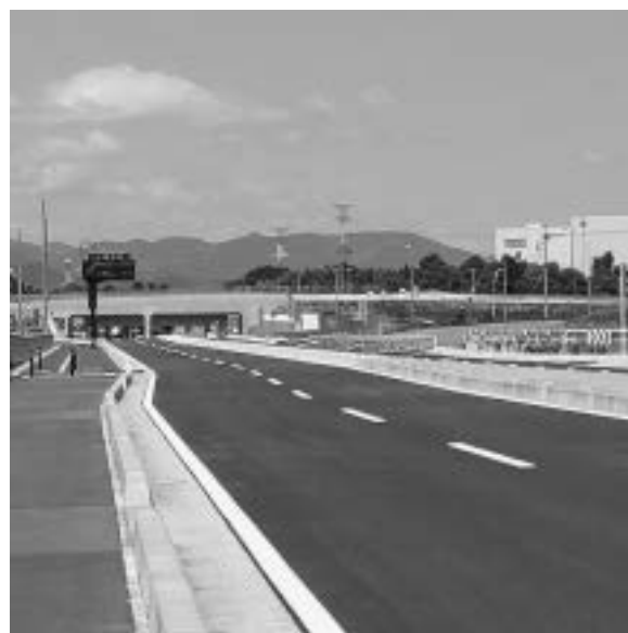
インターチェンジと接続した都市計画道路 川越鶴ヶ島線
