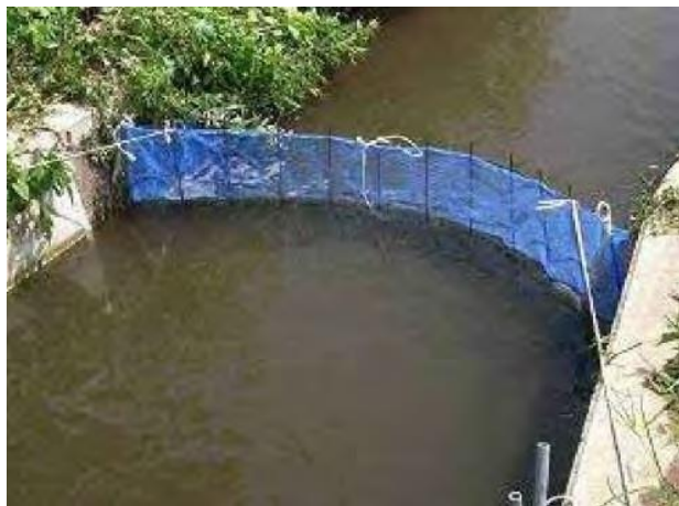
流出防止を目的とした網の設置例
