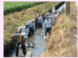
水路の泥上げ
