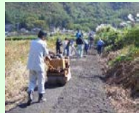
未舗装農道の舗装
