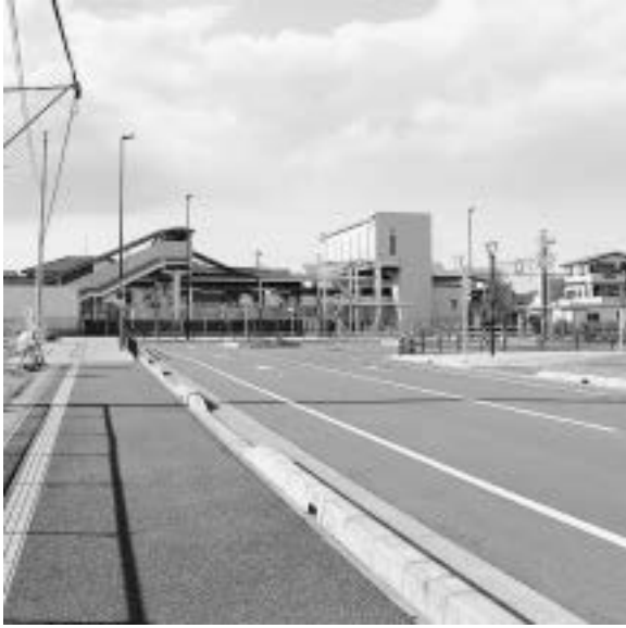
一本松駅南口駅前交通広場
