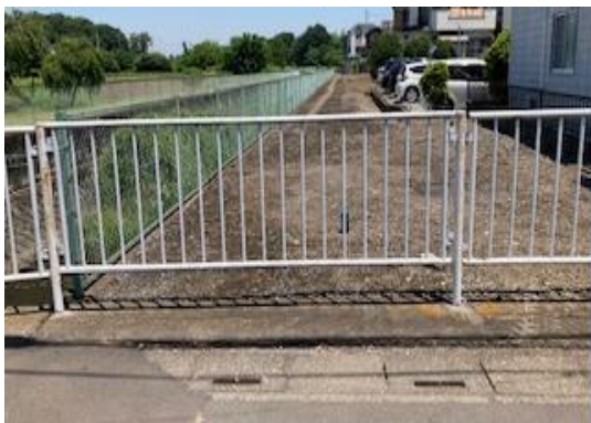
県道側から見た管理用地
