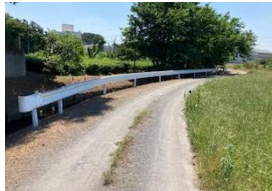
市道719号線 県道側から
