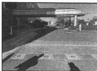
▲庁舎車寄せ改修工事箇所
