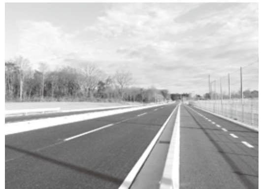
一般国道 407 号方面から運動公園方向
