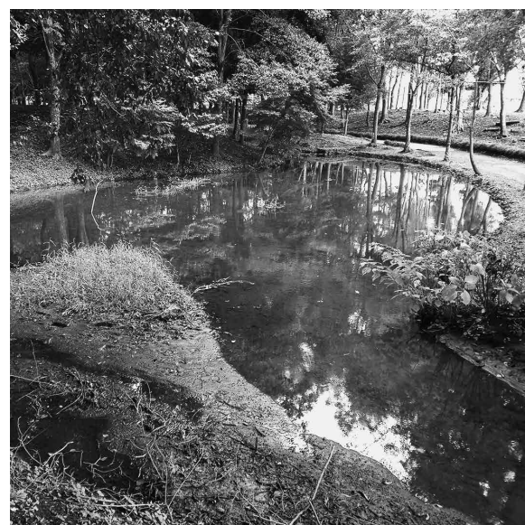
土砂が堆積したビオトープ
