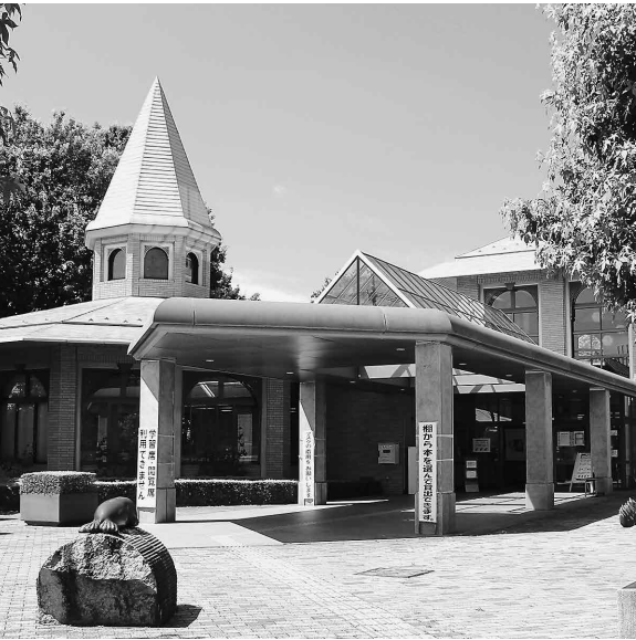
鶴ヶ島市中央図書館
