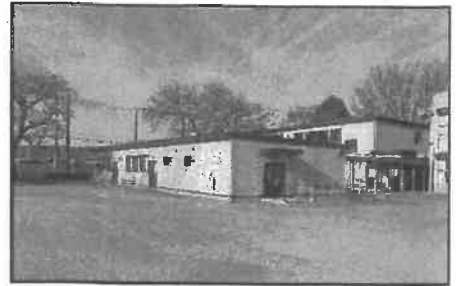
▲改修予定増築校舎
