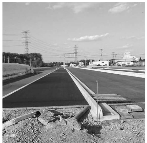
工事中の国道407号バイパス
