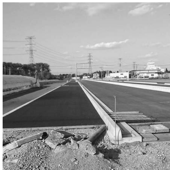
工事中の国道407号バイパス
