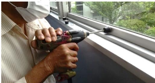
ガラス窓開閉ストッパー取り付け工事
