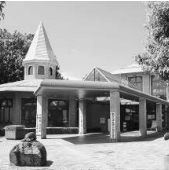
鶴ヶ島市中央図書館
