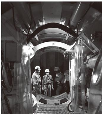
坂戸、鶴ヶ島下水道組合が施工する下新田地内の雨水管理設工事現場。施設内には、縦穴があり、安全ベルトを装着して約9mのはしごを下りると、とても涼しくひんやり。底に置かれた「シールド機」は直径2.7mほどの円筒状の機器で、地中を掘削し、内部でセグメントを組み立てながらトンネルを作っていきます。将来的には、一本松・新町方面への雨水管も埋設されます。
