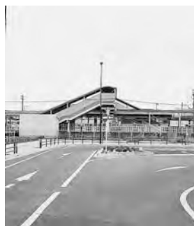
一本松駅南口駅前交通広場
