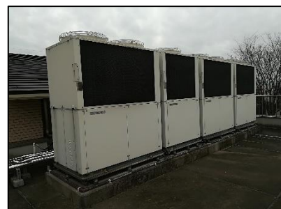
▲現在の空調設備エンジン
