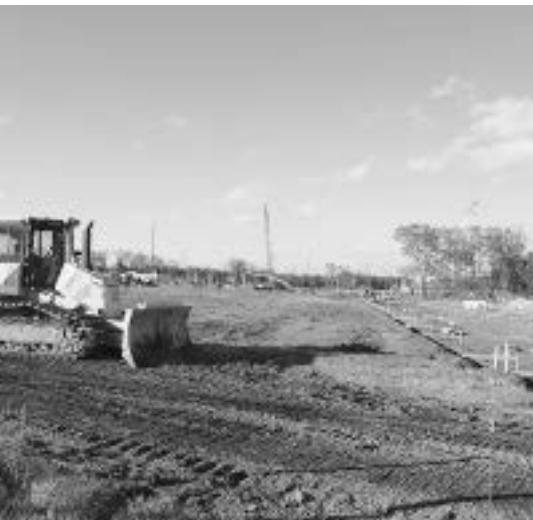
工事が進む埼玉県農業大学校跡地
