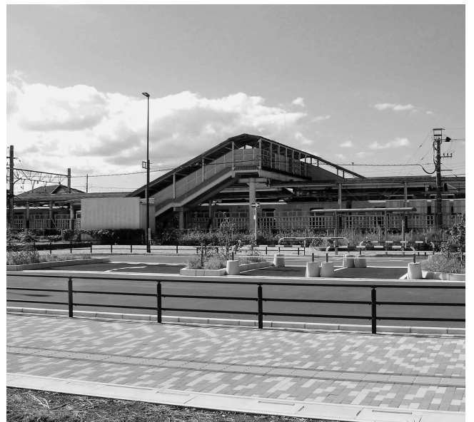
一本松駅南口駅前交通広場
