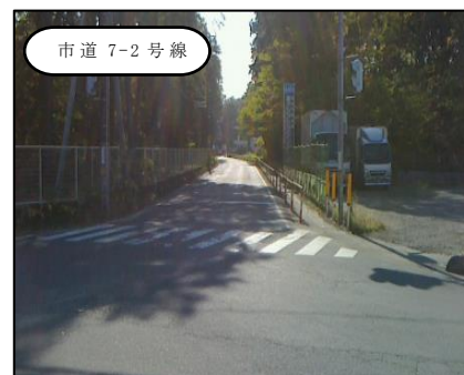
▲道路改良工事箇所
