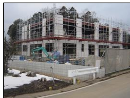
▲かもめ保育園建設中の様子
