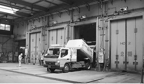
埼玉西部環境保全組合の高倉クリーンセンター
