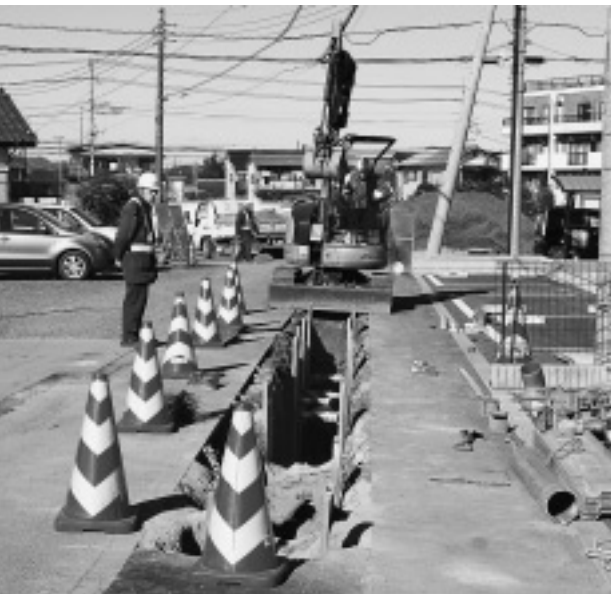
一本松地区地区計画区域内の下水工事
