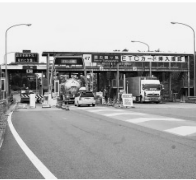
圏央鶴ヶ島インターチェンジ
