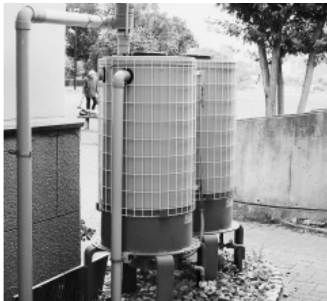
農村センターの雨水貯留タンク
