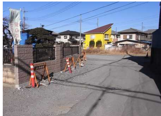
一本松地区の道路整備状況
