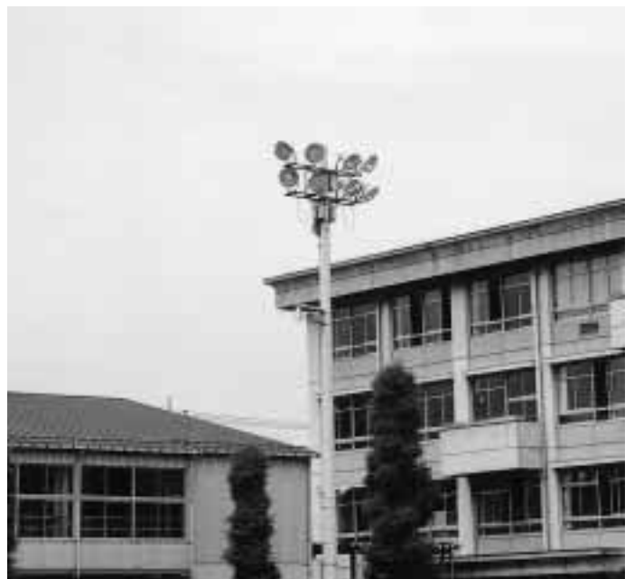
夜間照明が設置されている小学校（市外）
