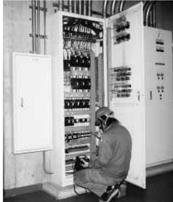
庁舎設備点検作業
