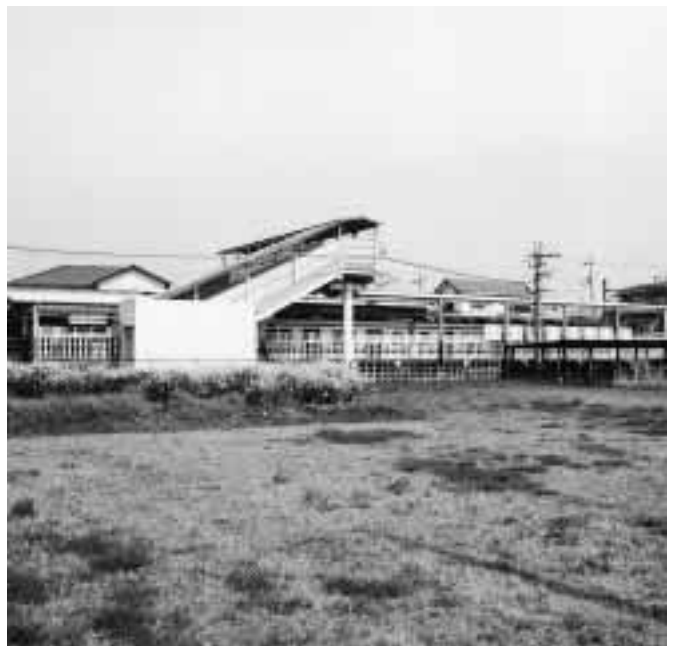
整備予定の一本松駅前
