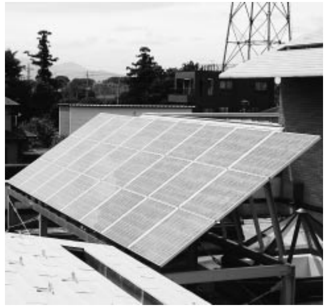
中央図書館の太陽光パネル
