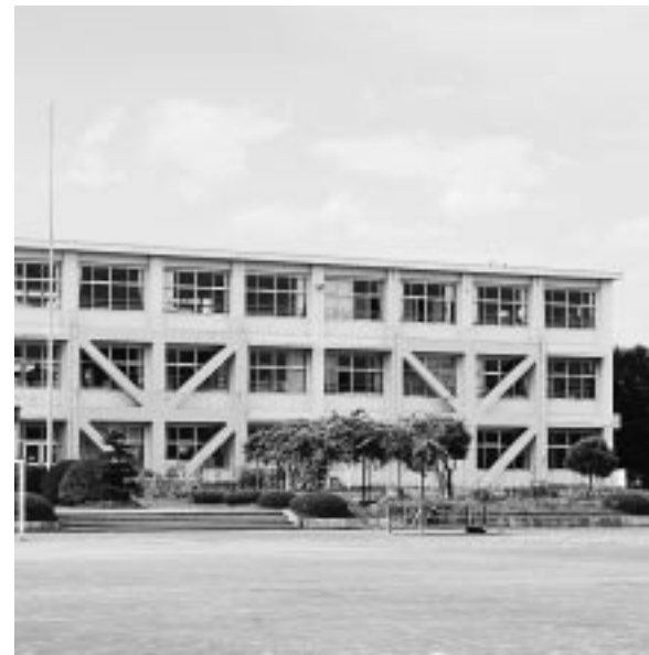
耐震化工事が終わった校舎
