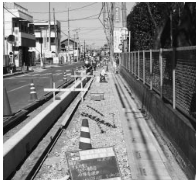
市役所通りの歩道整備工事
