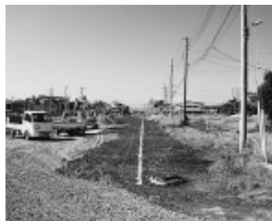
整備が進む若葉駅の西口地区
