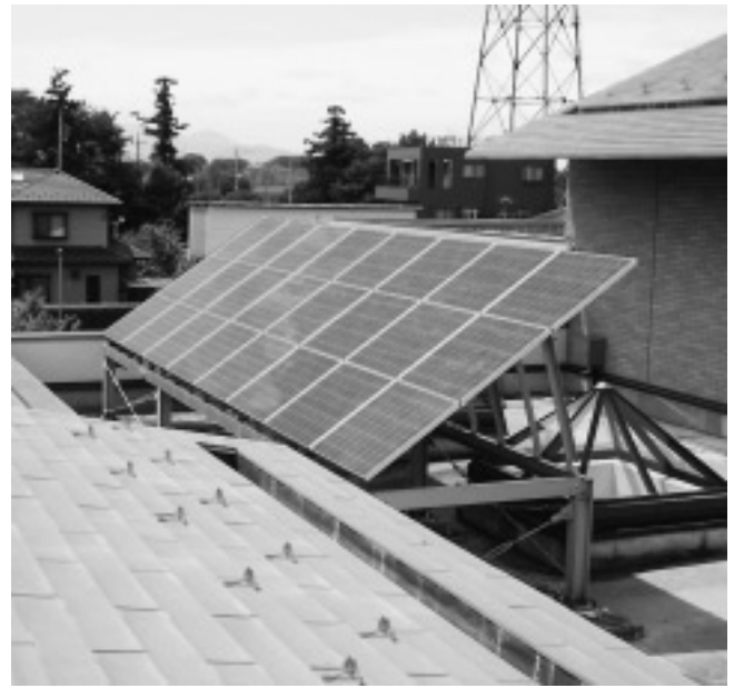
中央図書館の太陽光パネル
