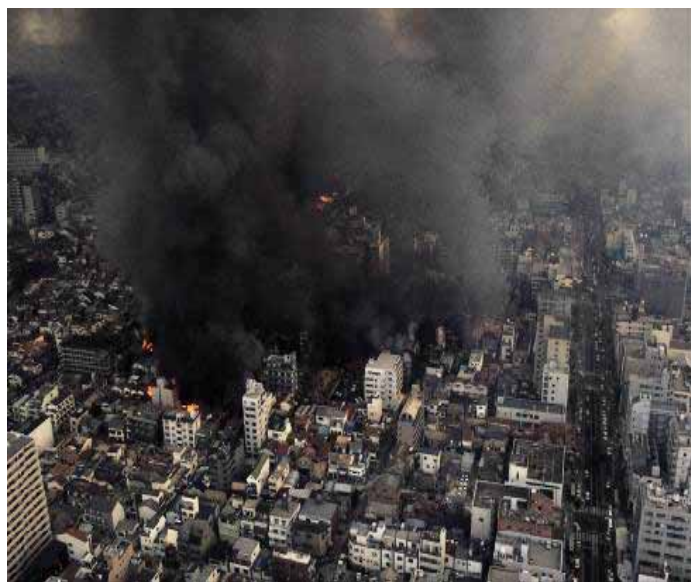
阪神・淡路大震災の被災状況
